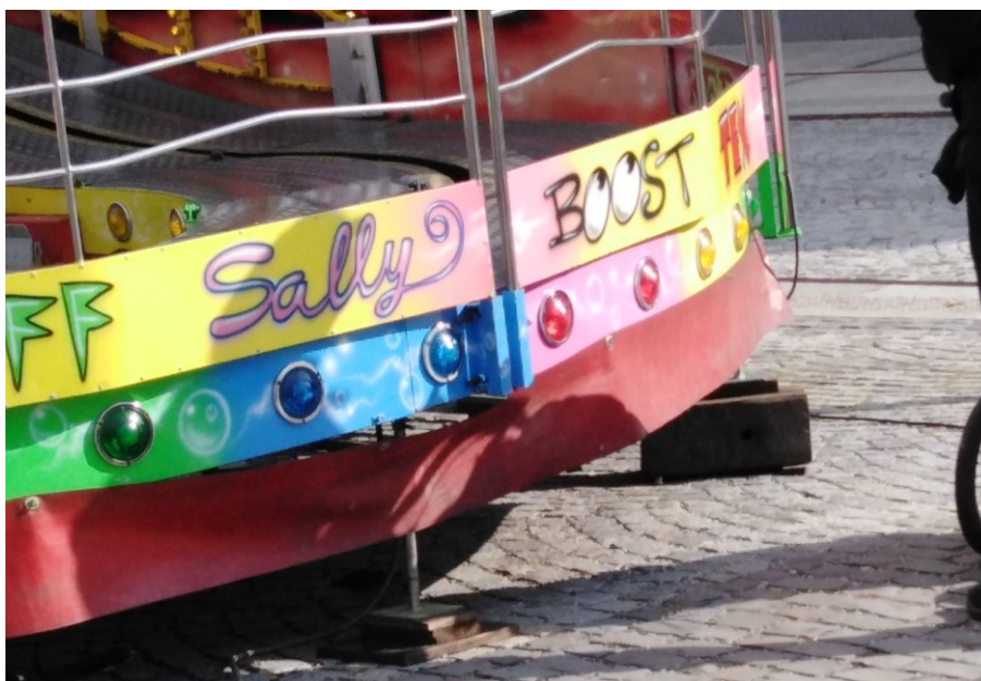
Obrázek 10. - Podložení atrakce (vlastní)
