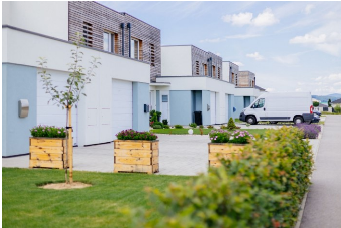
Obrázok 2 Radová výstavba Dlhé Diely (©Nová Dubnica – radové domy, 2020)
