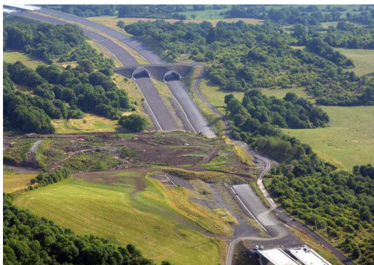
Obr. 2 Dálnice D8 po sesuvu půdy (12)
