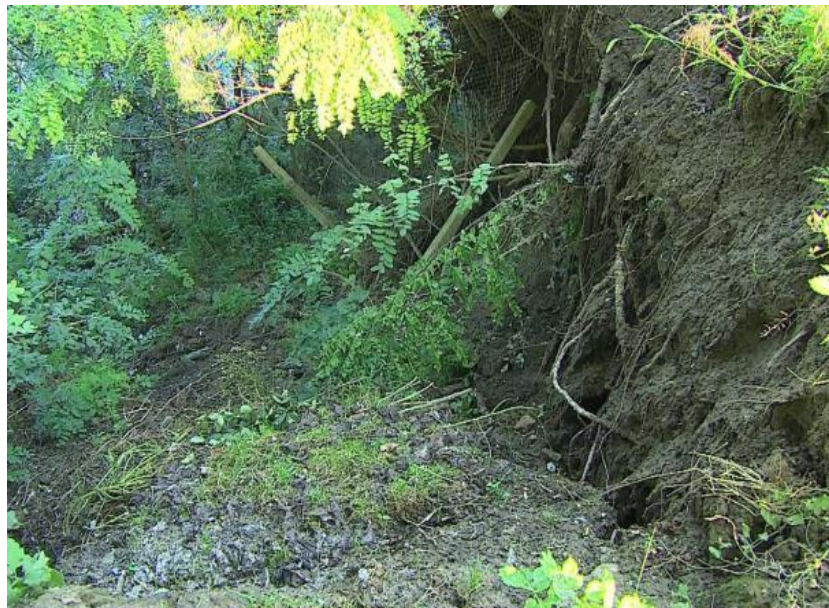
Obr. 13 Sesunutí svahu, Bulhary, zdroj vlastní
