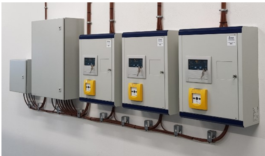
Obr. 7. Hasicí ústředny Esser [vlastní]
