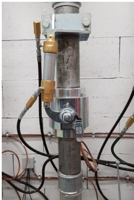
Obr. 13. Sekční ventil [vlastní]
