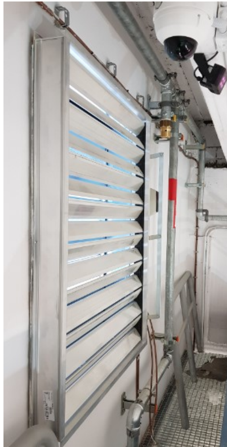
Obr. 15. Tlaková vyrovnávací klapka [vlastní]
