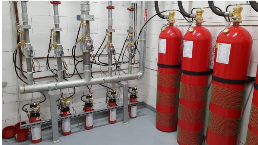
Obr. 12. Strojovna sekčního hašení [vlastní]
