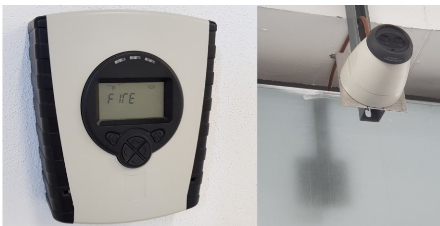
Obr. 5. Lineární hlásič Fireray [vlastní]
