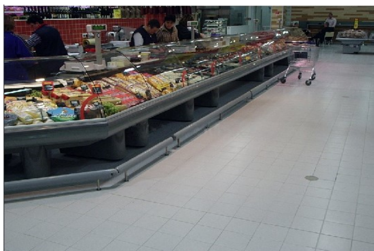
Obr. 33. Podlahové zvodidlá z polykarbonátu s hliníkovým jadrom chrániace vybavenie predajne. [49]
