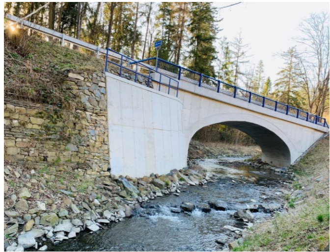
Obrázek 5: Pohled na kamenný most (vlastní foto)
