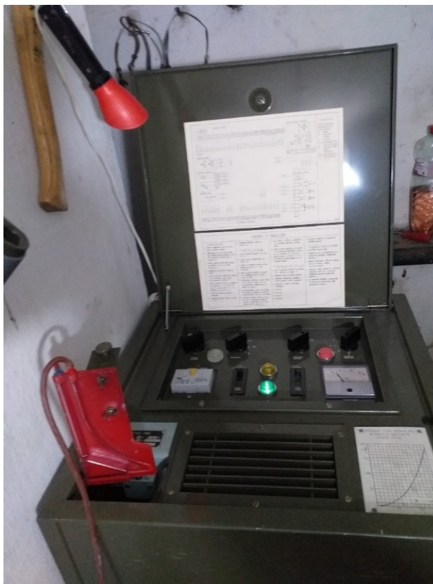
Obrázek 27 Měření přetlaku pomocí samotného FVZ-150 v objektu (Autor, 2021)
