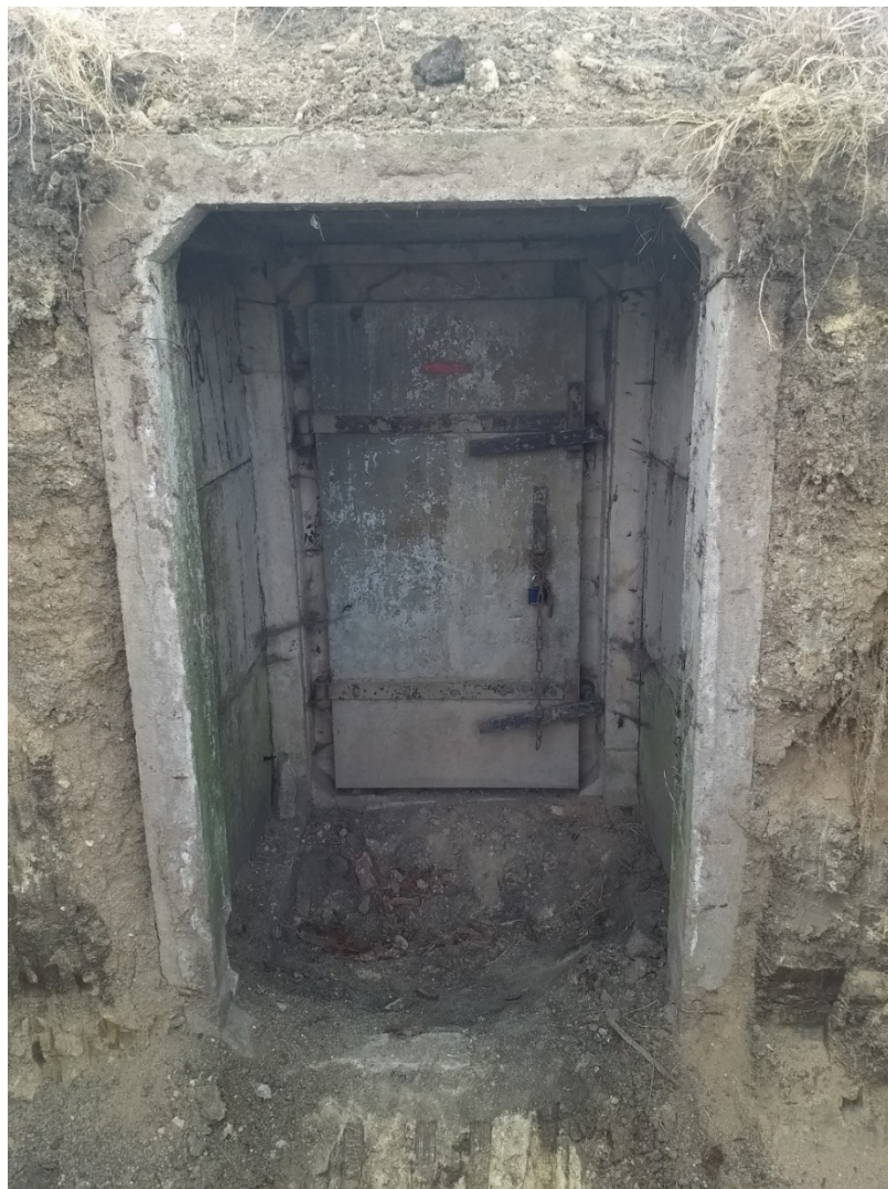
Obrázek 18 Starší typ protitlakových dveří v rámu Ždr2 (foto autora)
