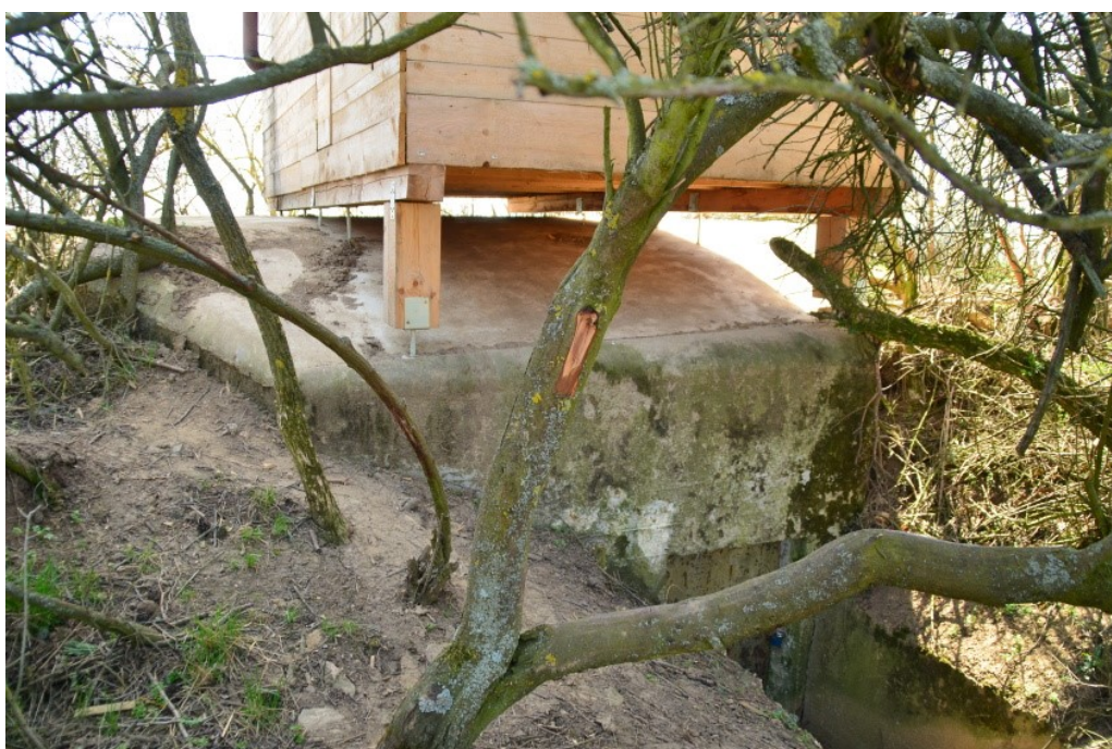
Obrázek 21 Pohled na ukotvení útulny ke stropnici objektu VEČ 206 (Řopíky.net, 2021)
