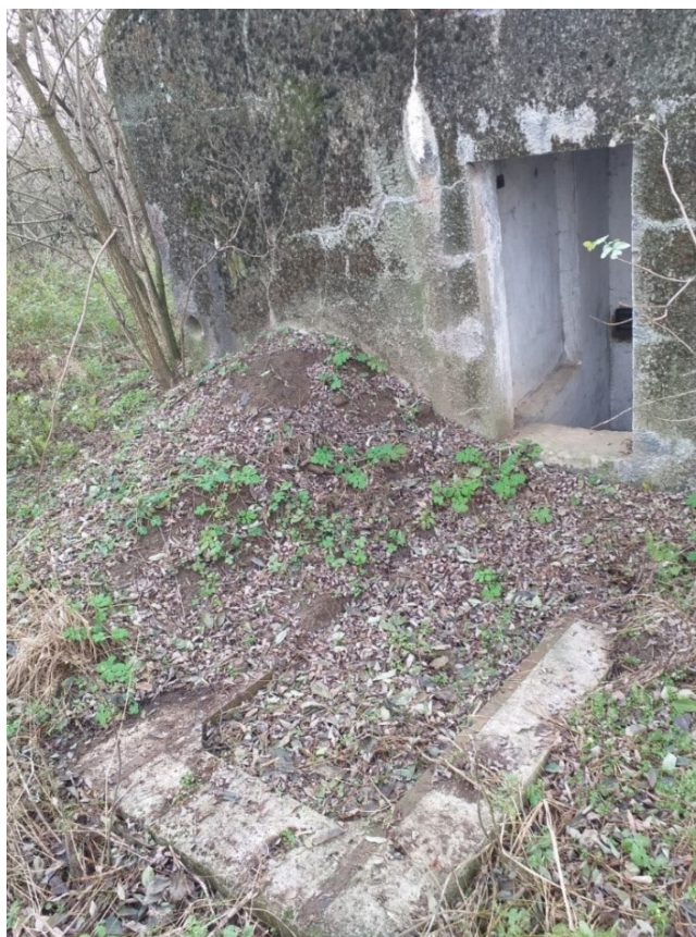
Obrázek 15 Odložený dveřní rám Žra 3 nerealizované prefabrikace (foto autora)
