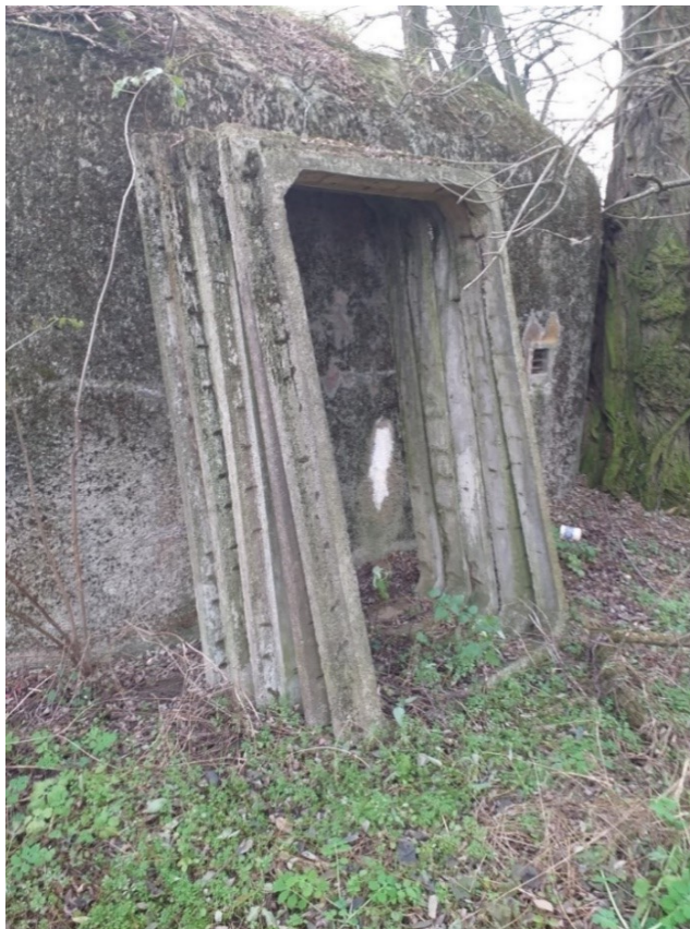
Obrázek 14 odložené rámy Žra 3 nerealizované prefabrikace (foto autora)
