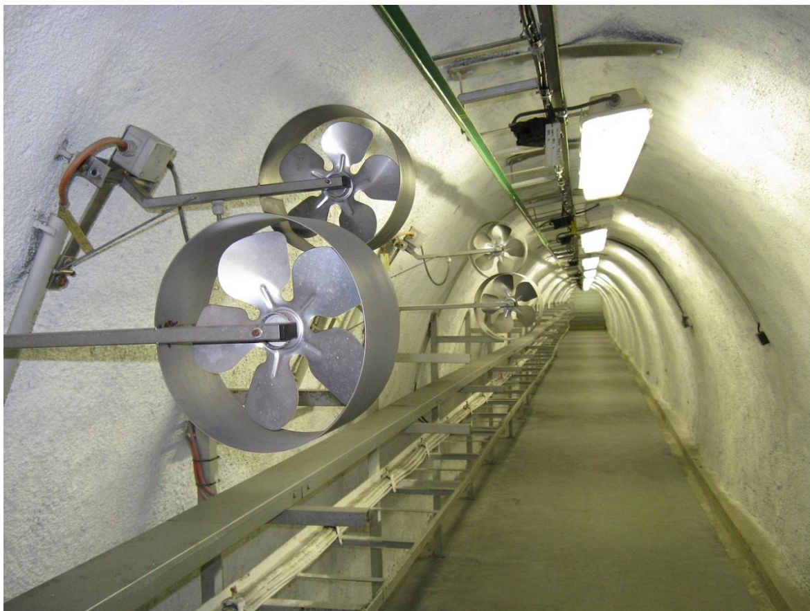
Obrázek 2 Vzduchotechnika v OS SAT (Město Praha, 2020b)
