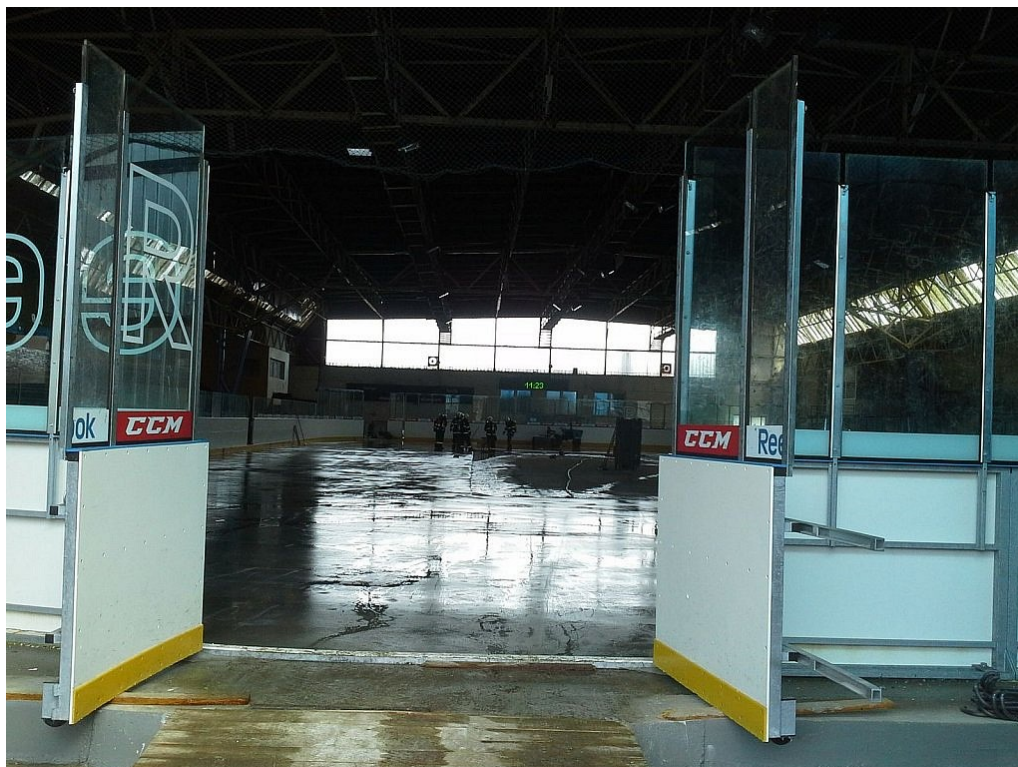
Obr. 5 – Na zimním stadionu v Rosicích unikl čpavek (Požáry.cz, 2013).
