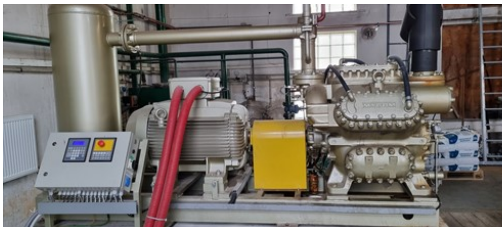
Obr. 16 – Kompresorové soustrojí (Vlastní).
