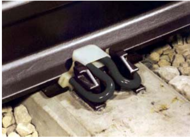
Obr. 2 Bezšroubová svorka Pandrol FastClip (2)
