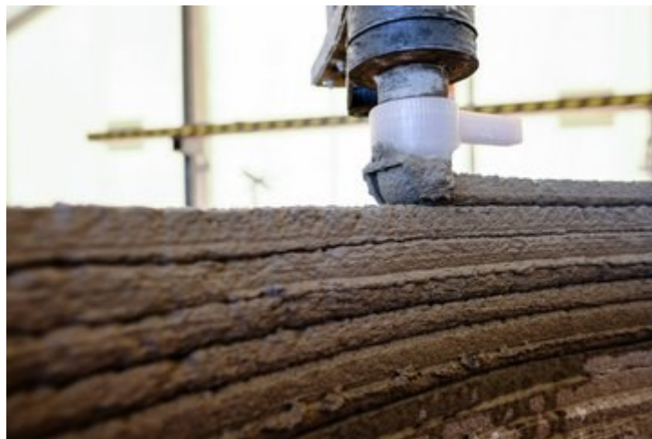
Obrázek 3. detail vrstev 3D tisku [11]
