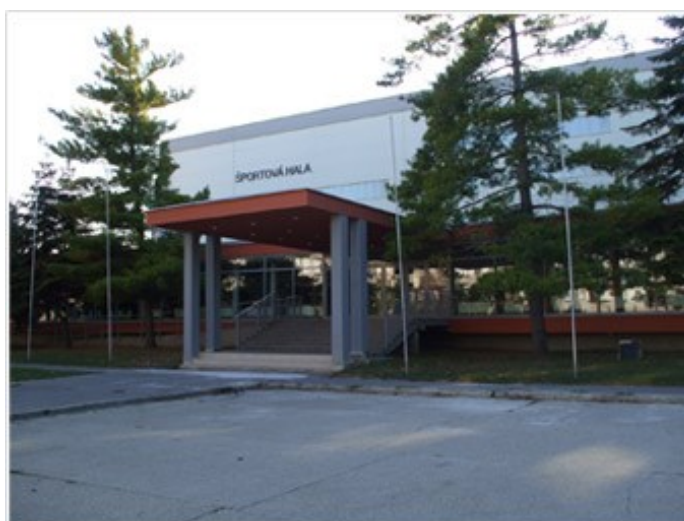
Obrázek 22 Mestská športová hala [zdroj: BKM Lučenec, 2021]
