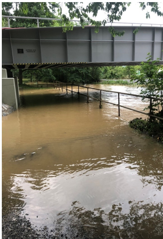
Obrázek 8 – Kulminace řeky Oskavy v Uničově (vlastní zdroj)
