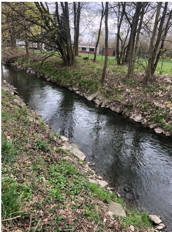
Obrázek 21 – Dosavadní zpevnění profilu koryta řeky (vlastní)
