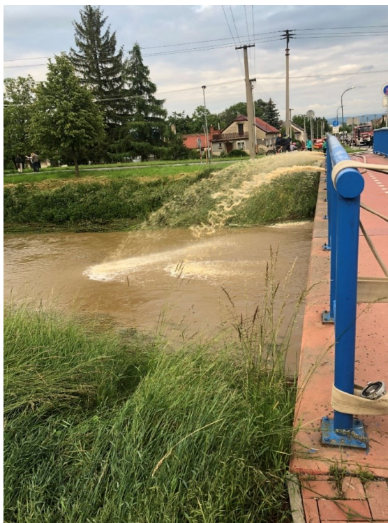
Obrázek 7 – Čerpání vody (vlastní zdroj)
