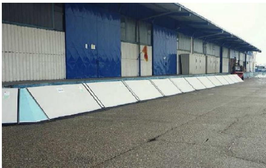
Obrázek 22 – Mobilní protipovodňové hrazení (Povodňový portál, ©2022)
