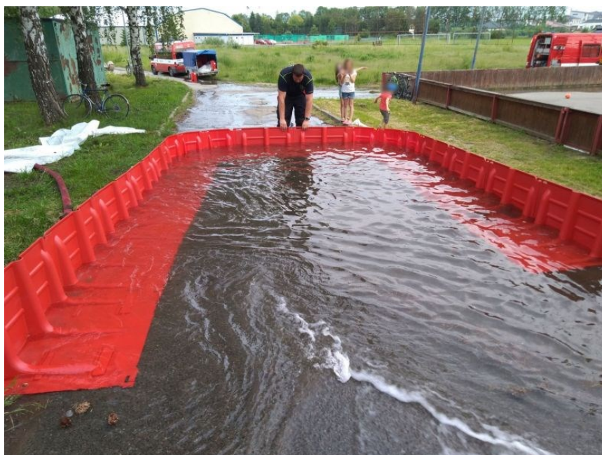
Obrázek 23 - Mobilní protipovodňová ochrana NOAQ Boxwall (Požární bezpečnost, s. r. o., ©2022)
