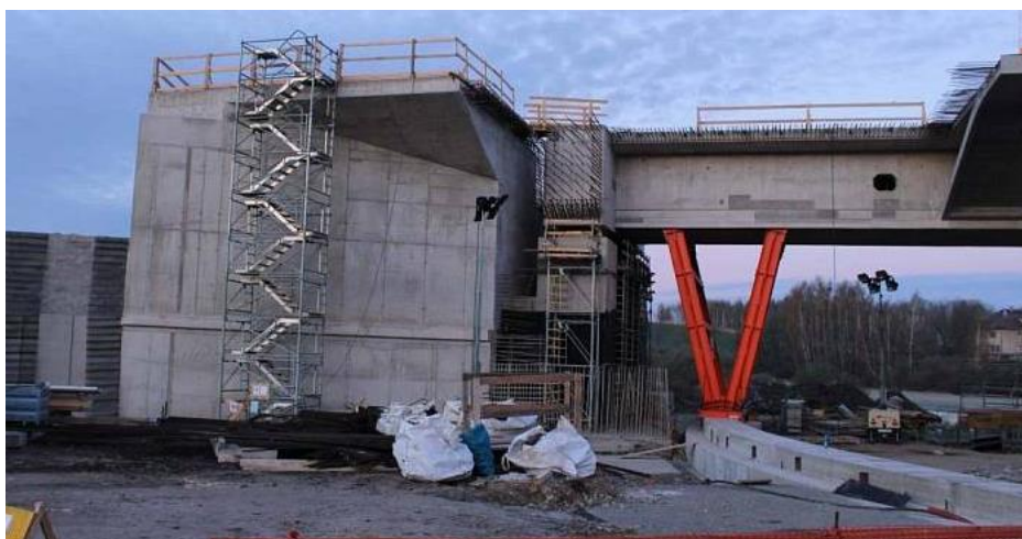
Obrázek 14 Konečná pozice první části mostu po otočení 18.4.2022
