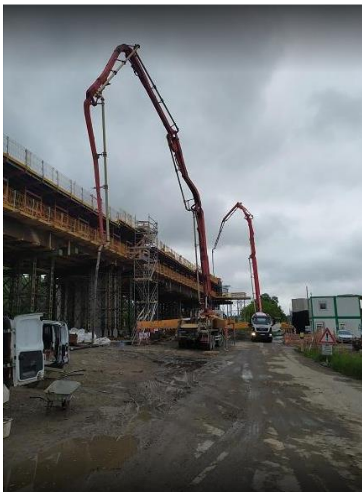
Obrázek 6 Stavba vahadla k 15.7.2021
