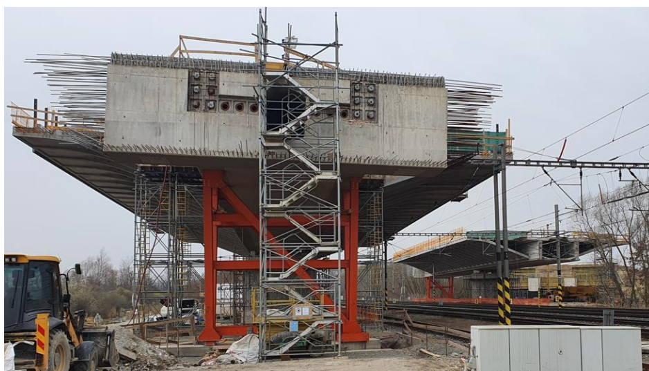
Obrázek 7 Stav vahadel krátce před otočením 29.3.2022
