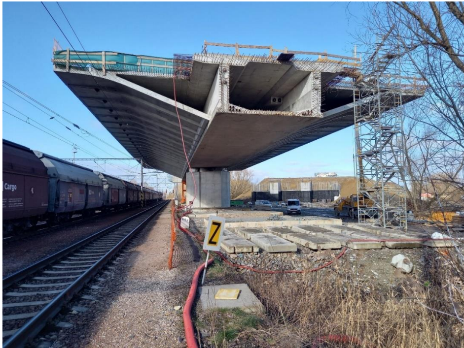
Obrázek 9 Vahadlo ve stavu dostavby před otočením + pilíř
