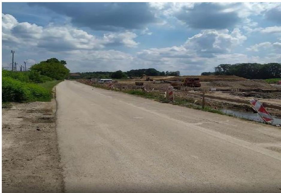
Obrázek 5 Zahájení stavby - zemní práce 20.7.2020
