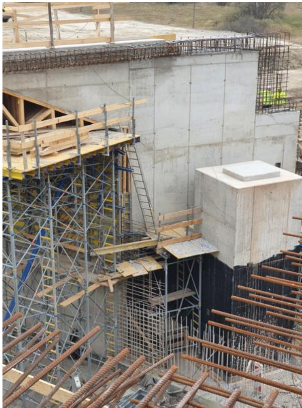
Obrázek 18 Žebřík bez zajištění
