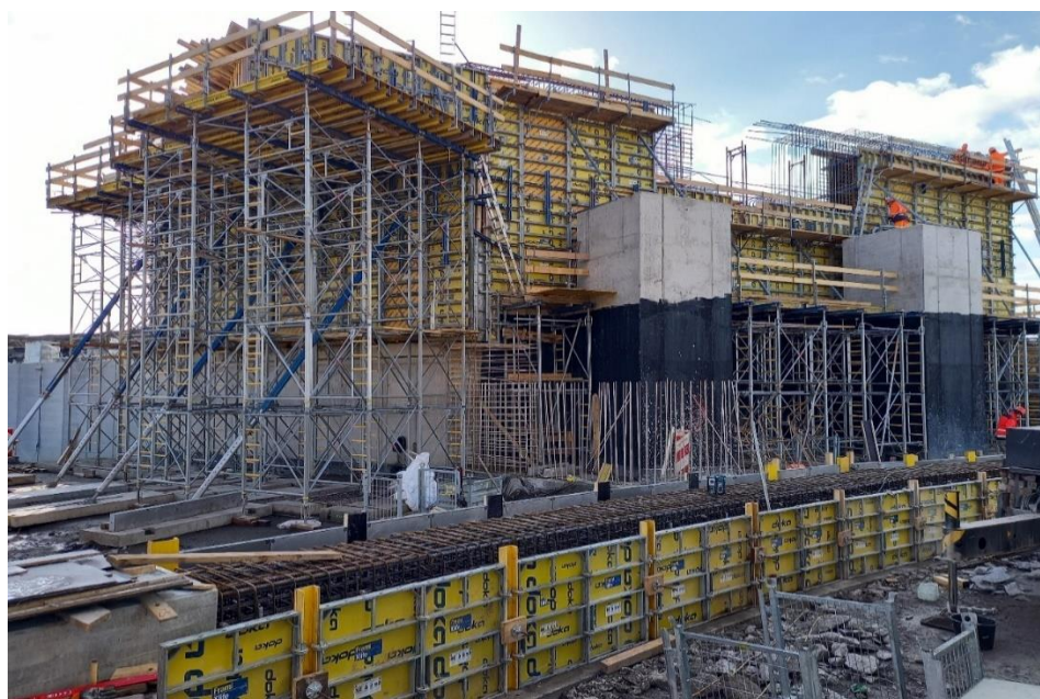
Obrázek 8 Pilíř a budovaná dráha pro otočení
