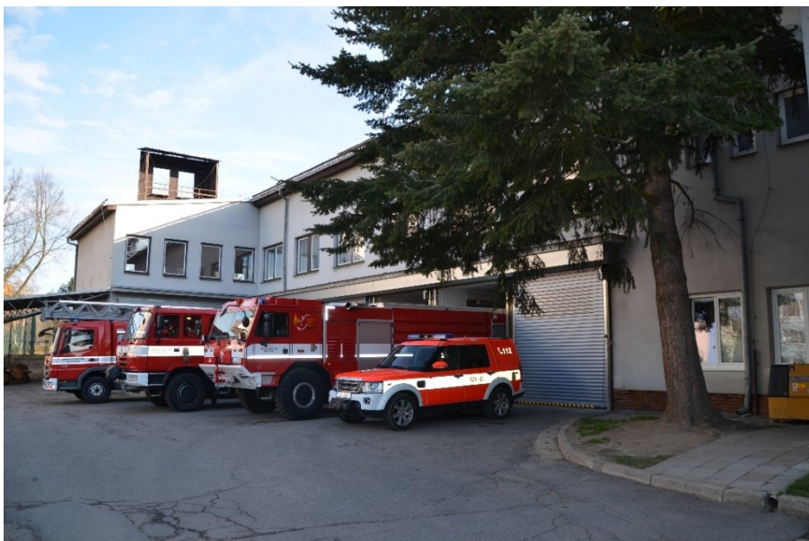
Obrázek 9 Stanice Velké Meziříčí (Roční zpráva o stavu požární ochrany Kraje Vysočina, 2021)
