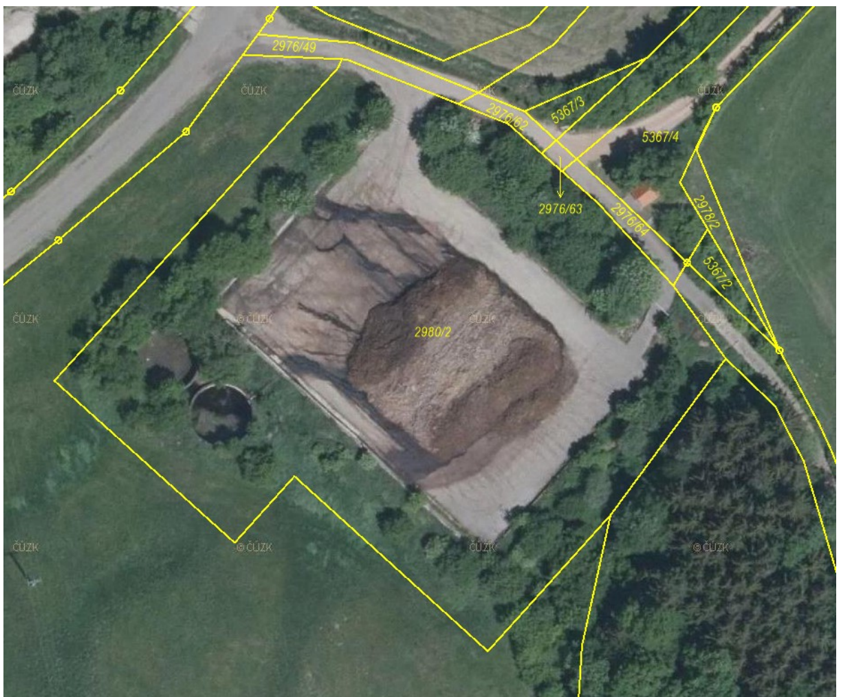
Obrázek 33 – Letecký pohled na hnojiště, včetně jímek na močůvku (vlastní).
