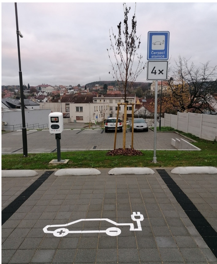
Obrázek 44 – Veřejné parkoviště za budovou MěÚ Bojkovice, kde je použita vsakovací dlažba Godelmann a nachází se zde také nabíjecí stanice pro elektromobily (vlastní).
