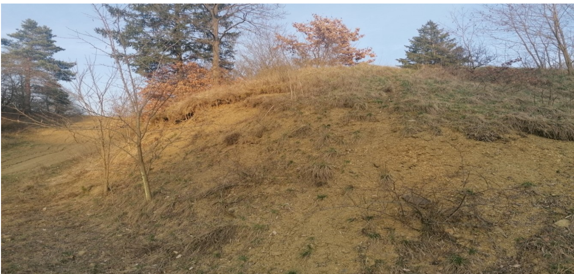
Obrázek 23 - Erozní procesy svahu s hlušinou (vlastní).
