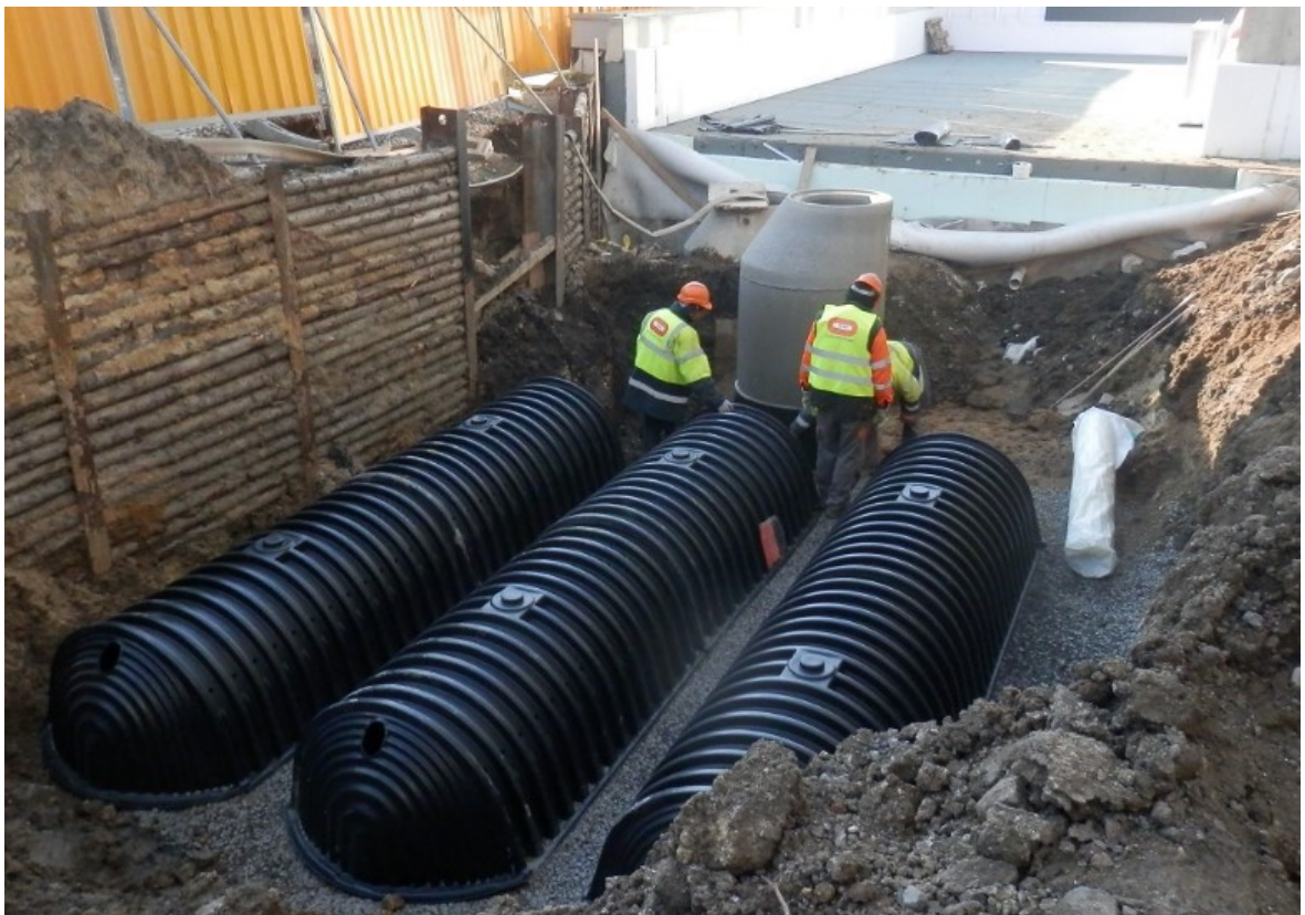
Obrázek 9 - Systém pro akumulaci a zasakování dešťových vod AS-KRECHT (Mrkývka, 2019).
