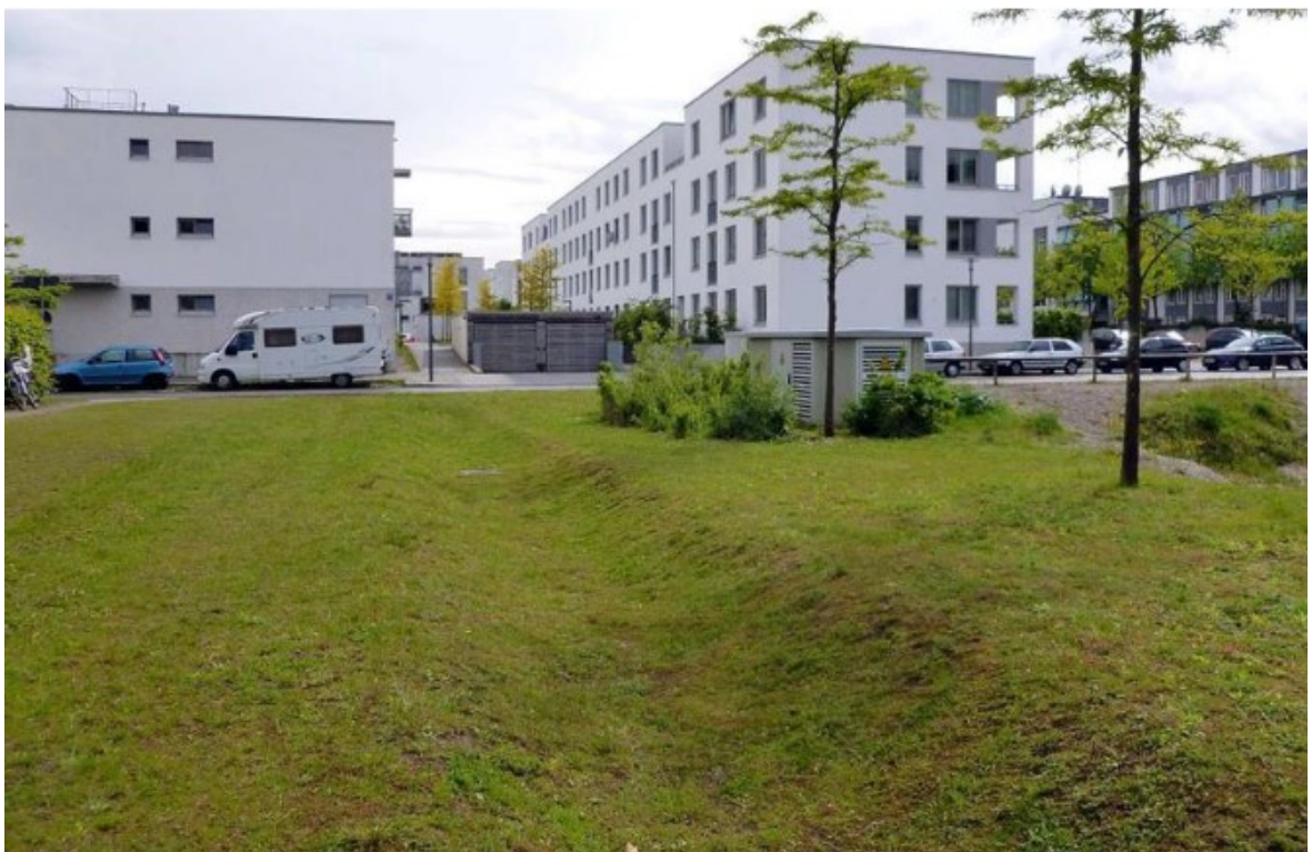
Obrázek 47 – Ukázka vsakovacího průlehu (Metodická pomůcka MMR, 2019).
