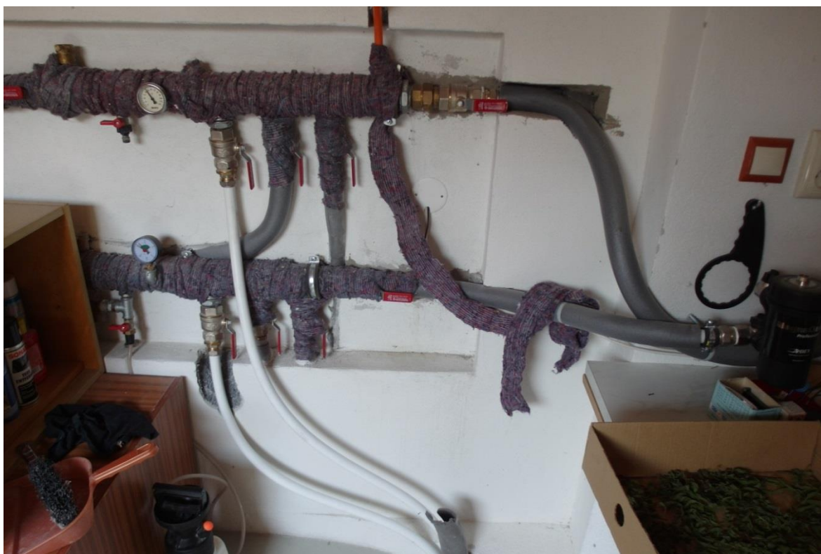
Obrázok 7. Rozdeľovací register kde je pripojené tepelné čerpadlo a novo pripájaný sporák (v procese inštalácie – chýba tepelná izolácia ).
