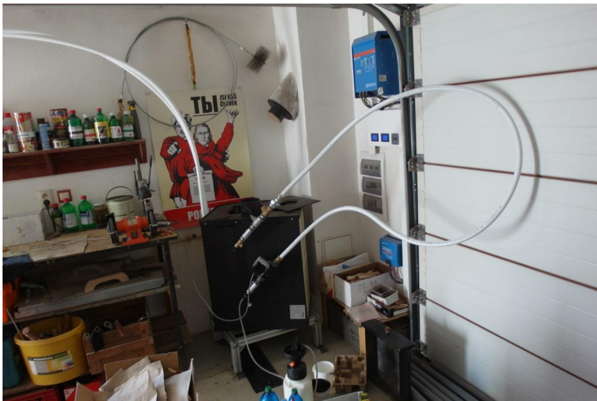
Obrázok 6. Tlaková skúška sporáku pred finálnou inštaláciou so základnou armatúrou.
