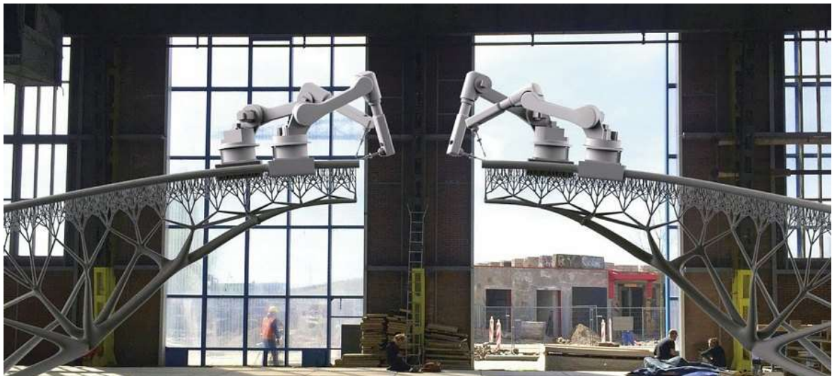
Obr. 1 Stavba domu aditivní technologií [10]
