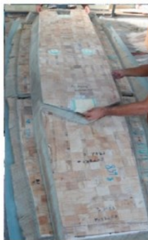
Obrázek 9 Položení balsového jádra do trupu lodi před infuzí pryskyřice [20]
