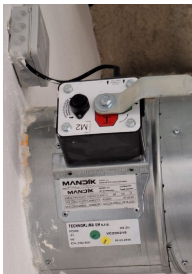
Obrázek 73 Protipožární mechanická klapka FDMB Mandík[1]
