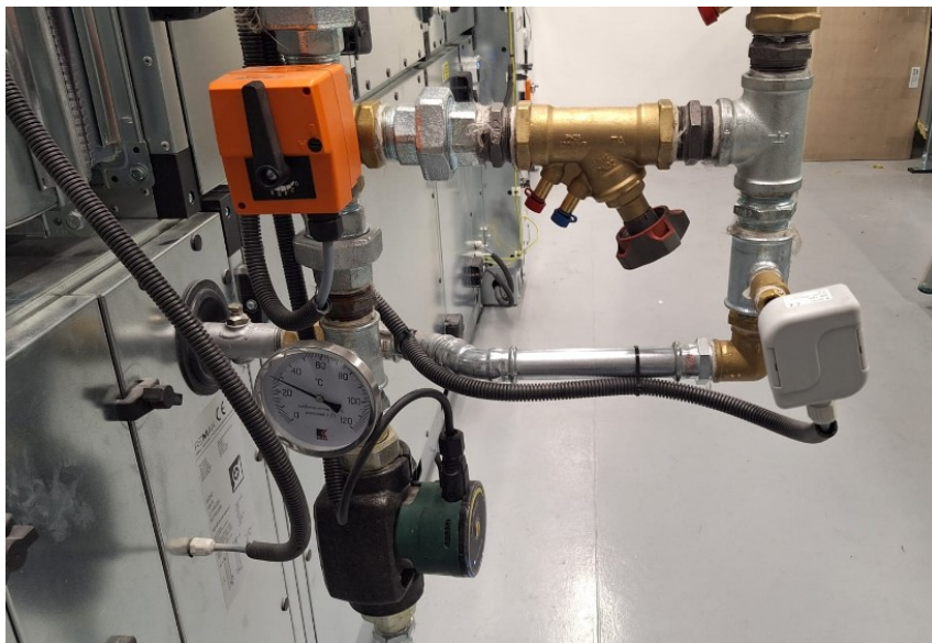
Obrázek 70 Směšovací větev pro ohřev vzduchu[1]
