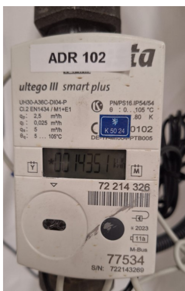
Obrázek 88 Připojený měřič tepla na rozdělovači s adresou 102[1]
