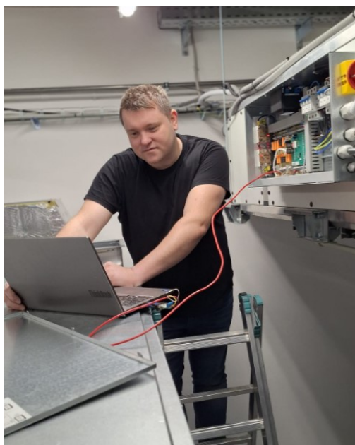
Obrázek 96 Testování komunikace MODBUS RTU jednotky DHVAC [1]
