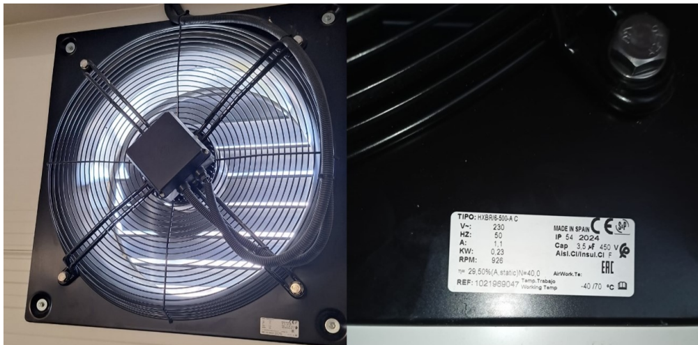
Obrázek 77 Štítek a realizace odtahového ventilátoru HXBR/6-500 AC[1]
