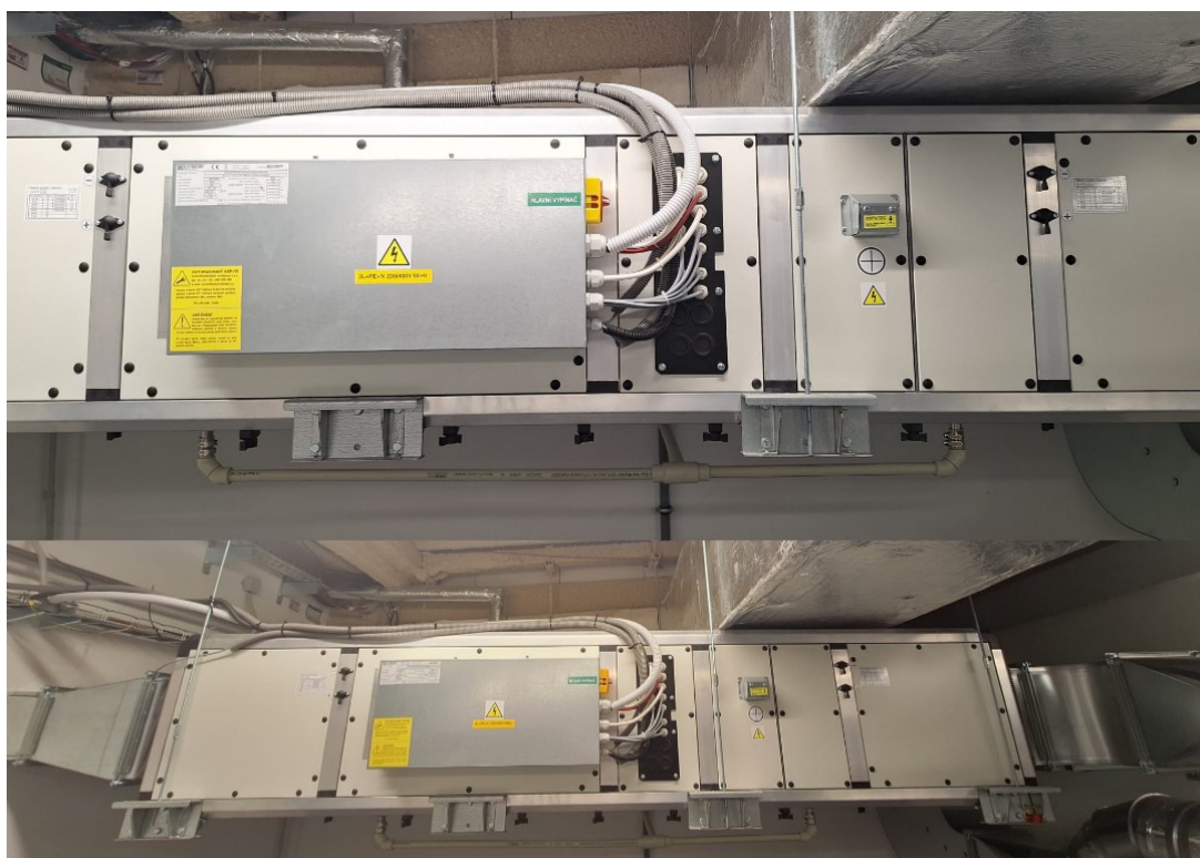
Obrázek 74 Vzduchotechnická jednotka Elektrodesign DHVAC-(M) CRT [1]
