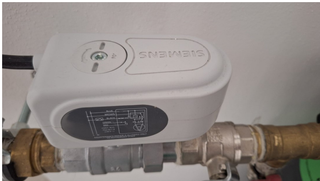
Obrázek 57 Elektrický ventil pro dopouštění vody do systému [1]
