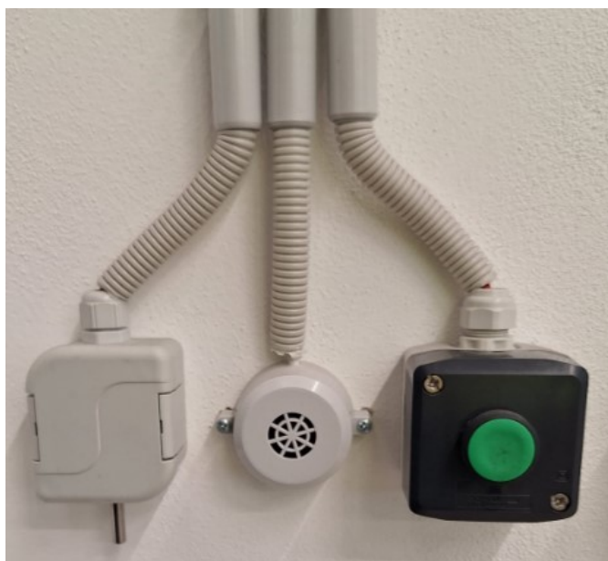
Obrázek 75 Senzory a ovládací tlačítko pro větrání skladů a servisů[1]
