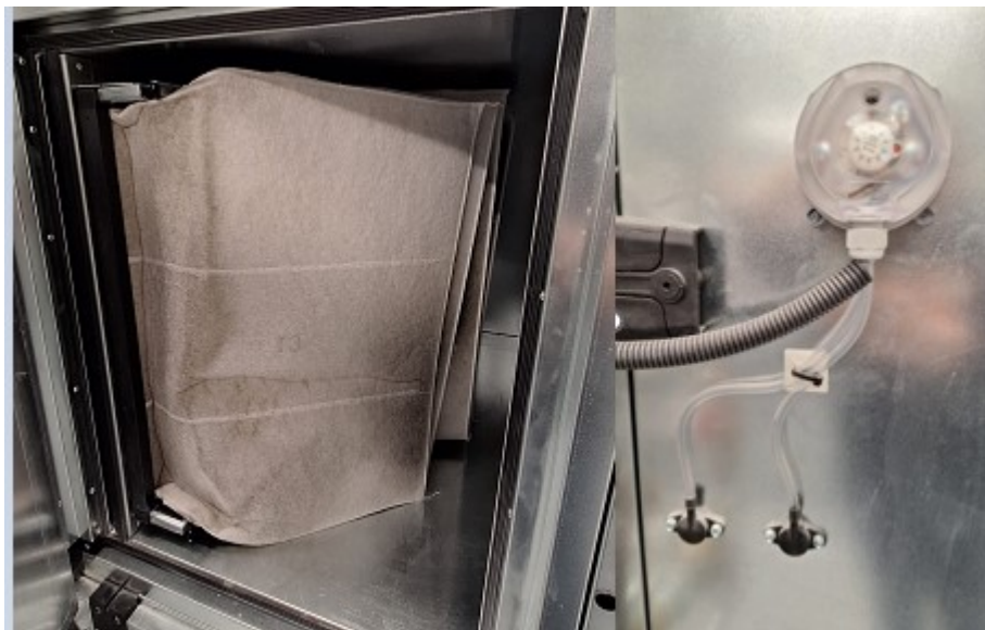
Obrázek 66 Filtr na přívodu VZT a diferenční manostat DM 300[1]
