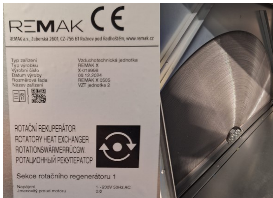
Obrázek 68 Štítek a konstrukční provedení rotačního rekuperátoru[1]
