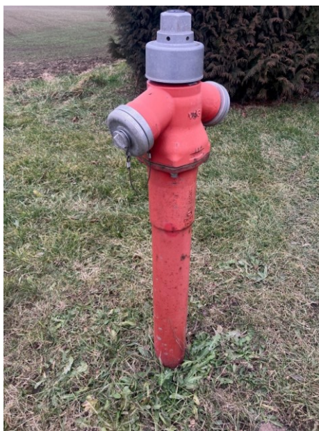
Obrázek 16: nadzemní hydrant
