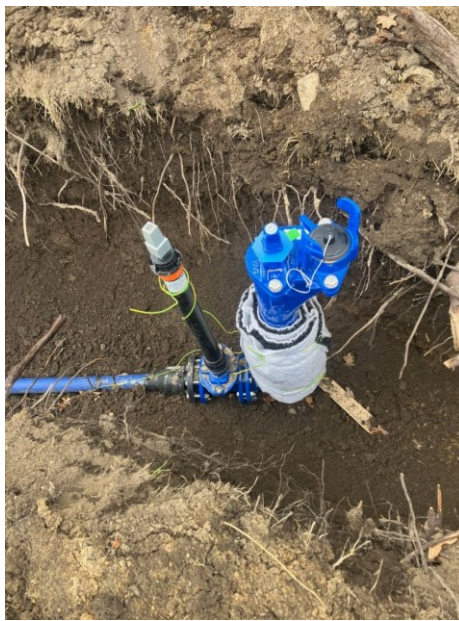
Obrázek 15: Podzemní hydrant
