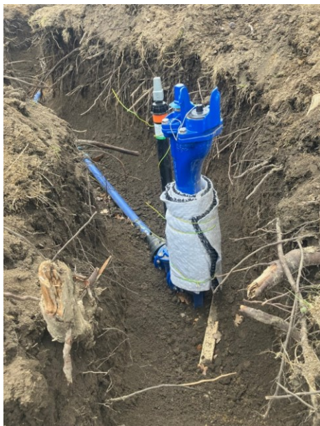
Obrázek 15: Podzemní hydrant
