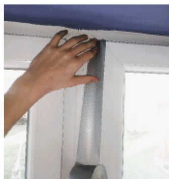
Obrázek 3 Utěsnění okenních otvorů pomocí lepicí pásky
