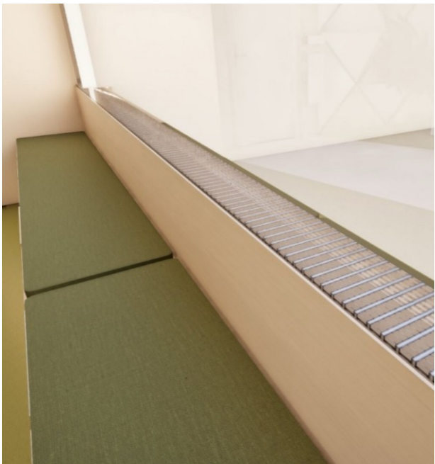
Obrázok 24 - Obloženie radiátora (zdroj: vlastný)
