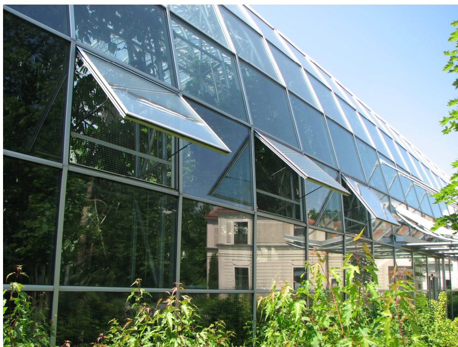
Obrázek 24 : Fotografie automaticky otevíracích bočních oken.
