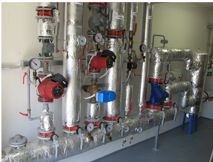
Obrázek 25 : Fotografie sruženého rozdělovače – sběrače ÚT.
