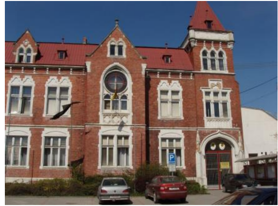
Obr. 24. Sídlo městského úřadu Kravaře.
