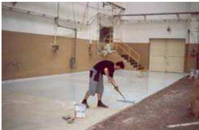
Obr. 3. Aplikace polyuretanové chemické izolace [13]
