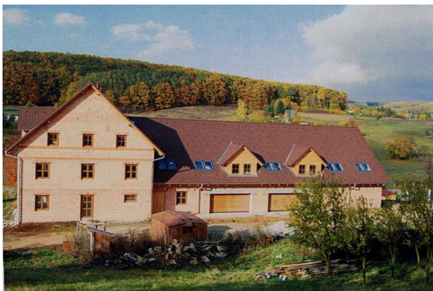
Obr. 5 Výchozí stav – bližší pohled na objekt.
