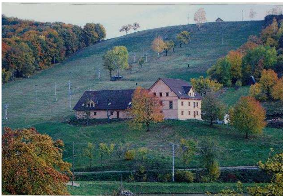
Obr. 4 Výchozí stav – celkový pohled na objekt.
