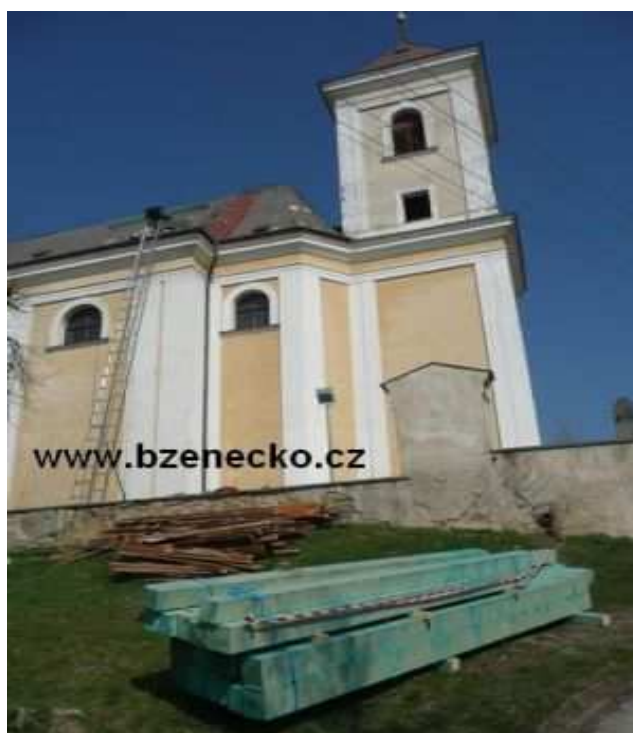
Obr. 15. Kostel Obrácení sv. Pavla v Syrovíně před realizací projektu
