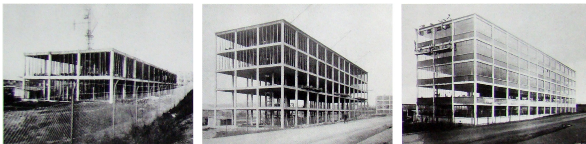
Obr. 6: 3 fáze výstavby strojírny
