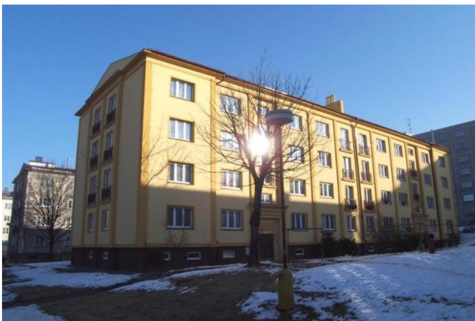
2. Panelový dům G - 40
