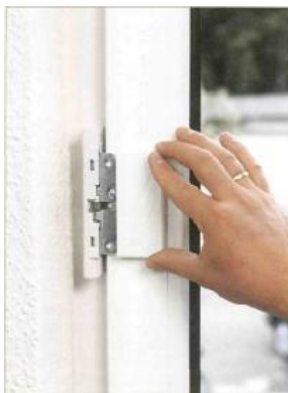
Obr. 17 Pojistka proti nadzdvížení závěsu okna
