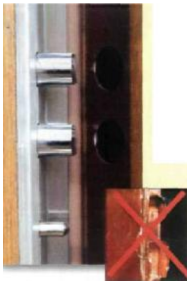
Obr. 12 Bezpečnostní zárubeň
