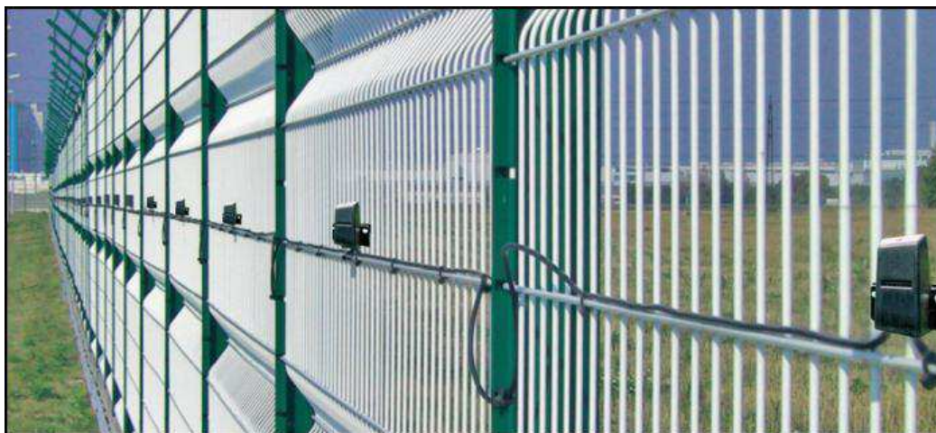
Obrázek 1: Perimetrický detekční systém – oplocení s detektory [8]
