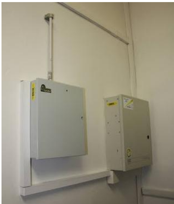
Obrázek 15: Ústředna EZS na Katastrálním pracovišti ve Zlíně [vlastní snímek]
