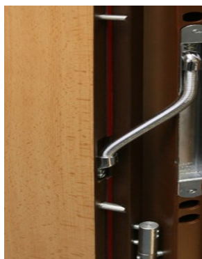
Obr. 39 Bezpečnostní dveře s kabelovou přechodkou
