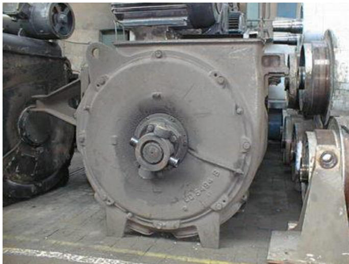
Obr. 6 Motor FIR před opravou
