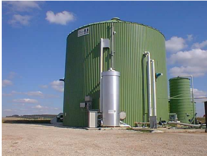
Obr.5. Fermentor na bioplynové stanici Phalheim [28].
