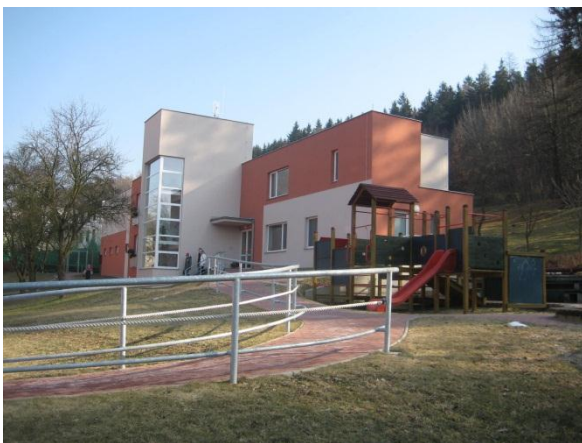
Obr.2. Pohľad na budovu domova, S-Z
