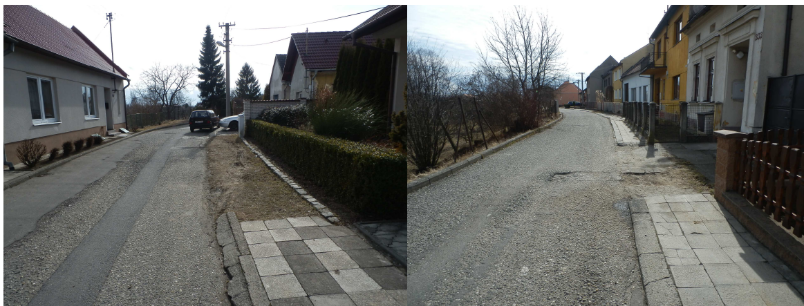
Obr. 2. Místní komunikace a chodník v ulici „Záhonce“
