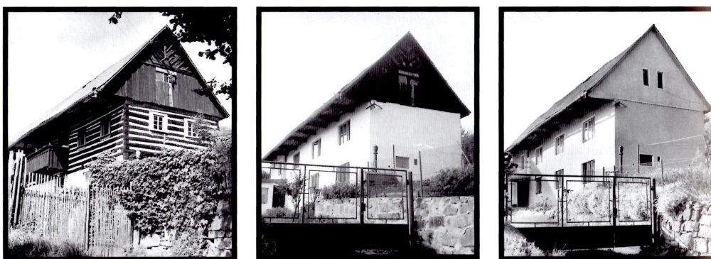
Obr.9. Tři fáze proměny typické tradiční severočeské stavby.
