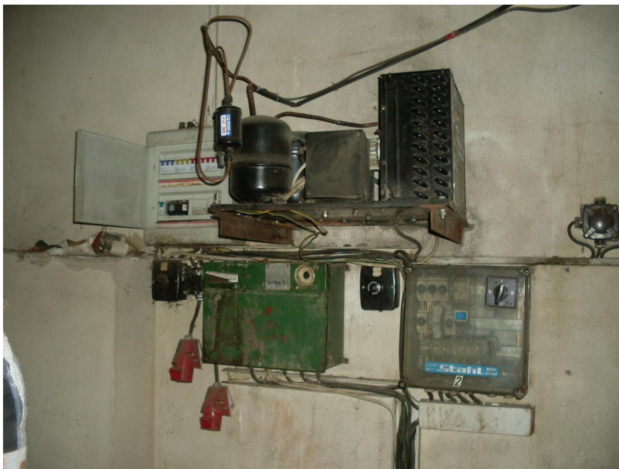
Obr. 8 Pojistky generátoru [zdroj : vlastní, 2012]
