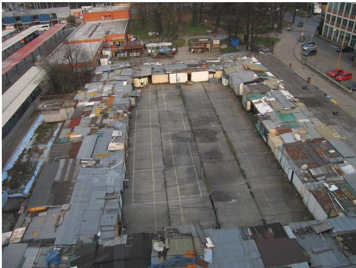
12/ pohled na současný stav tržiště
