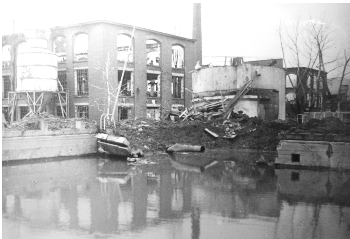
8/ pohled na poškozené koupaliště-filtrační stanice, vlevo zničené budovy č. 15 a 16
