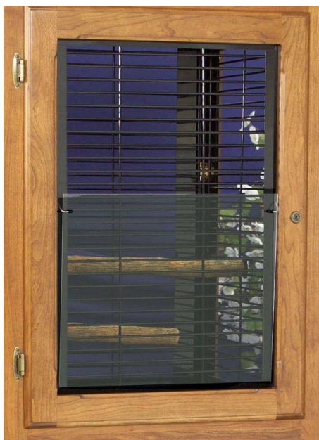
Obr. 40: Prachové chrániče jsou vlastně obyčejná „plexiskla“ vložená před mřížoví.
