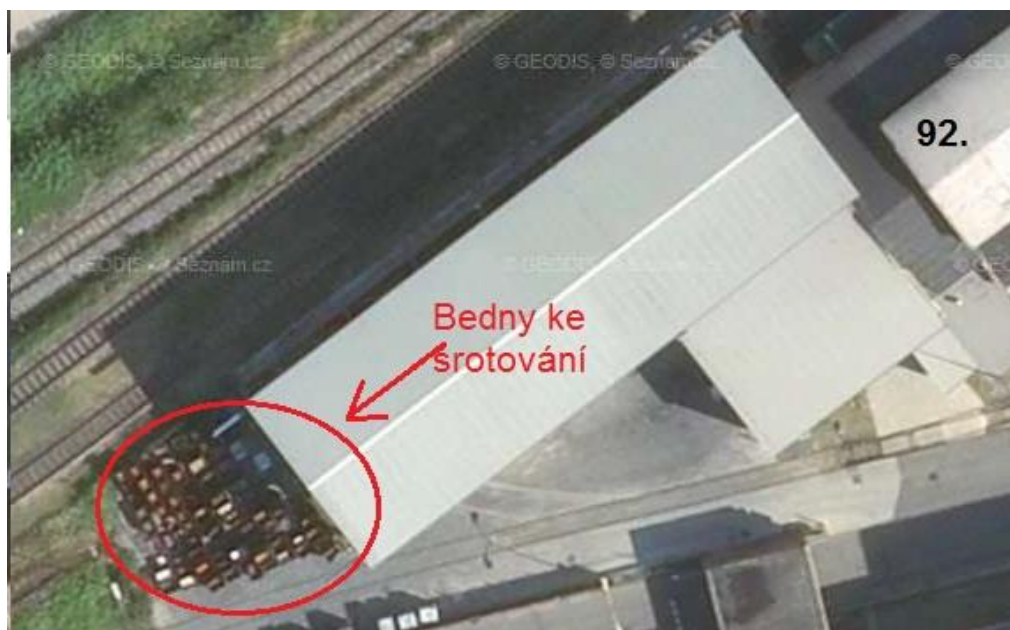
Obr. 33 Místo s uložením nepoužívaného obalového materiálu (zdroj: vlastní zpracování)
