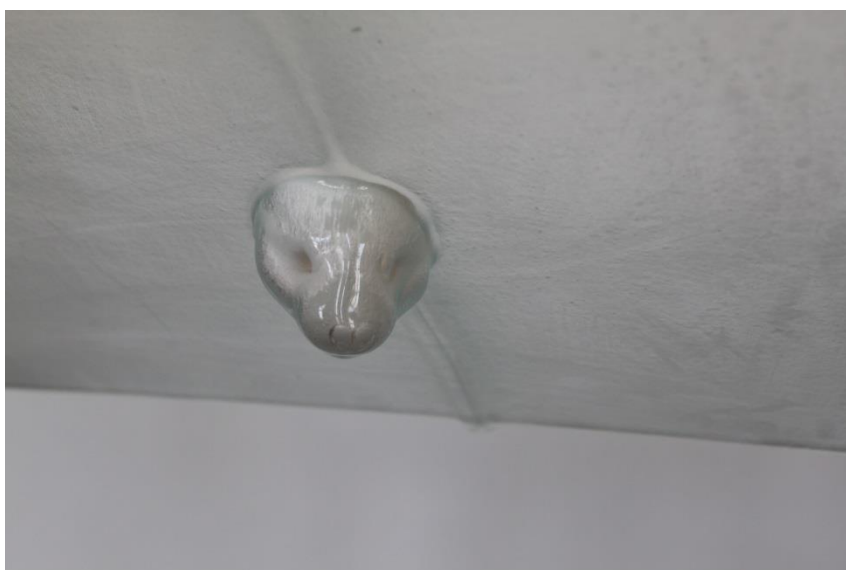
Obr. 37 Lehané sklo, stěna akvária
