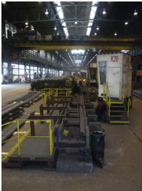
Obr. 27. Čelní pohled na doúpravnu, v popředí kotoučové nůžky. (Vlastní zpracování)
