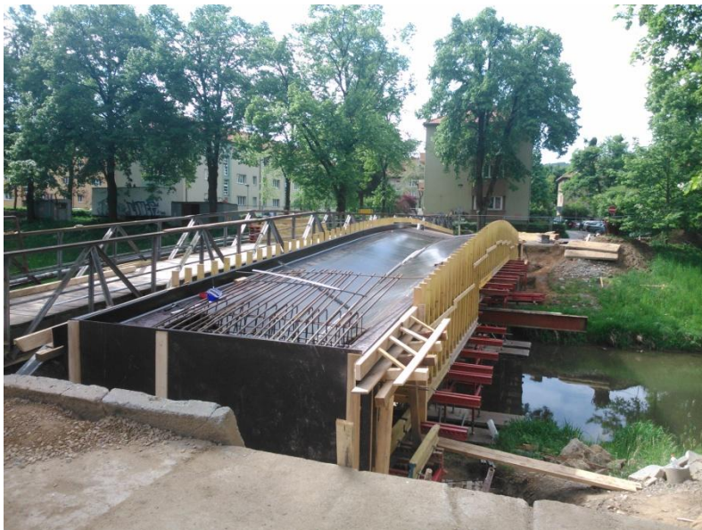
Obr. 65 Ocelové pruty v mostní konstrukci
