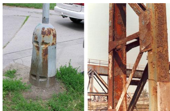
Obr. 18 Ukázka koroze
