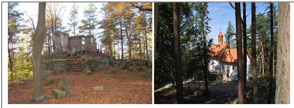
Obr. 18: Stav kaple před opravou - říjen 2007, dokončená oprava – srpen 2009
