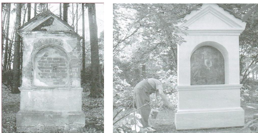
Obr. 27: Horní zastavení křížové cesty (před opravou a po opravě)
