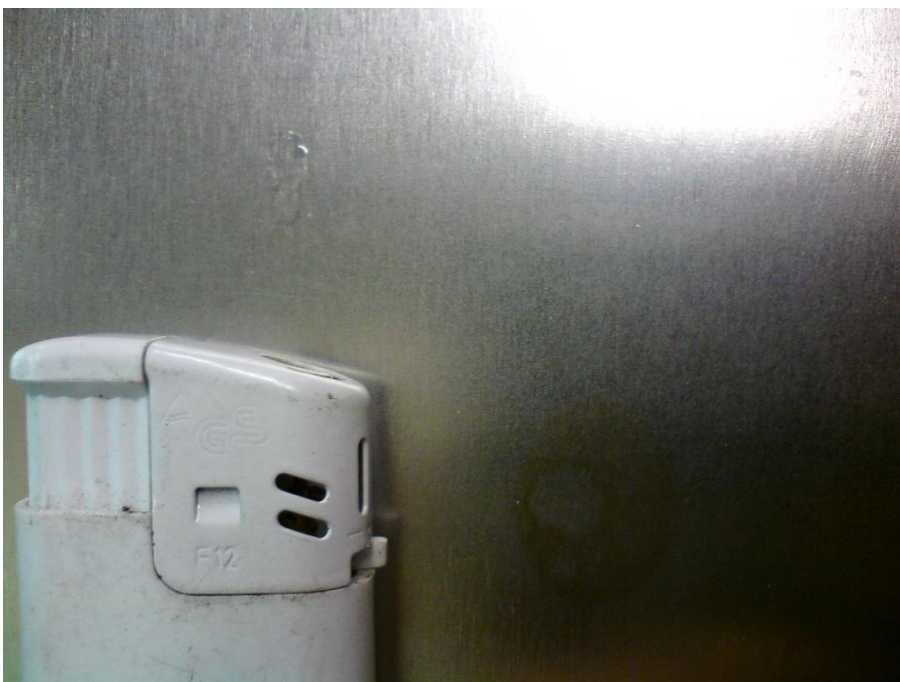
Obr. 41 Začištění plochy po navaření
