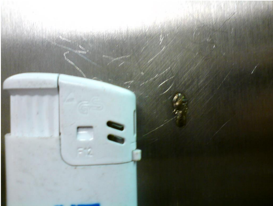
Obr. 40 Navaření chybějícího materiálu
