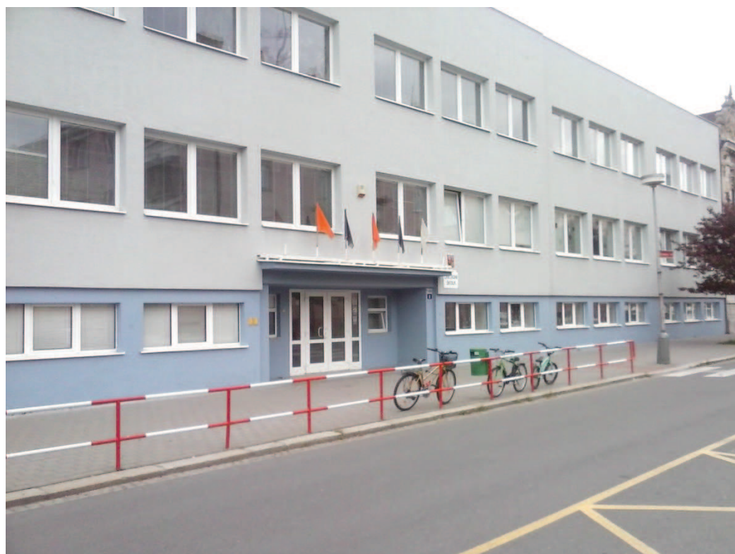
Obr. č. 14 Základní škola U Sýpků [zdroj vlastní]
