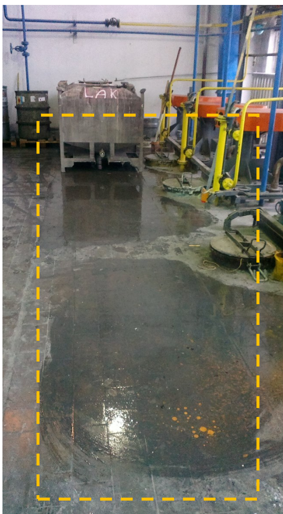
obrázek 15: nádrž, u níž je proveden penetrační nátěr. Zdroj [vlastní]
