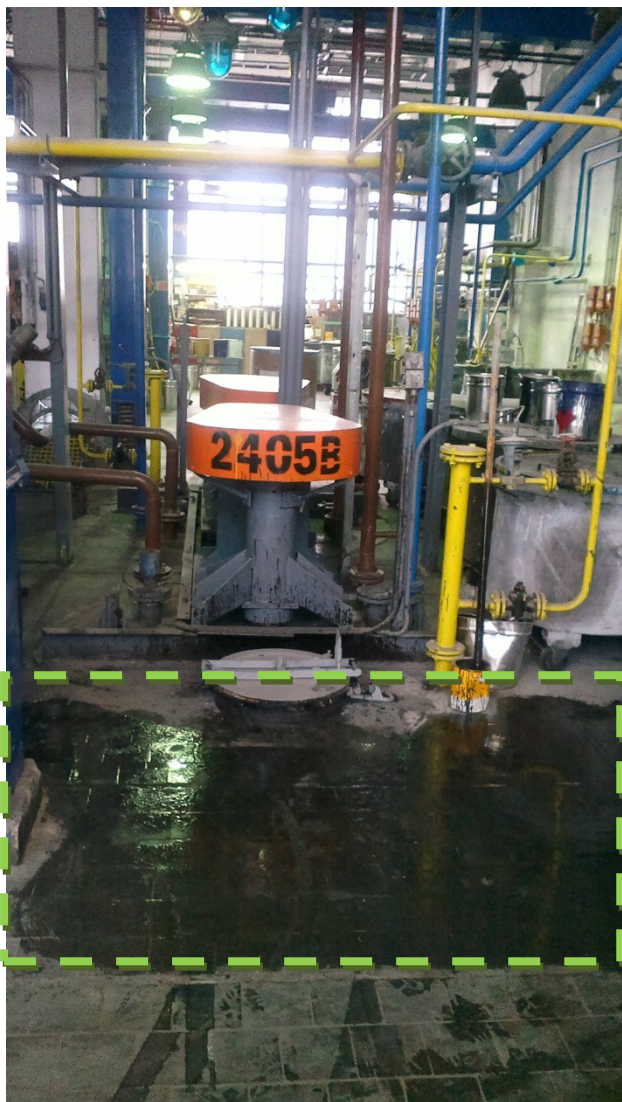
obrázek 14: nádrž, u níž je proveden penetrační nátěr. Zdroj [vlastní]
